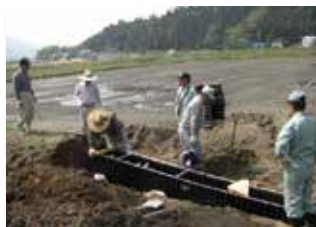
水田魚道の設置
